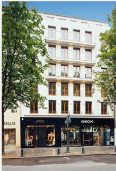
▲ Palisanderholzfenster in der Fassade
