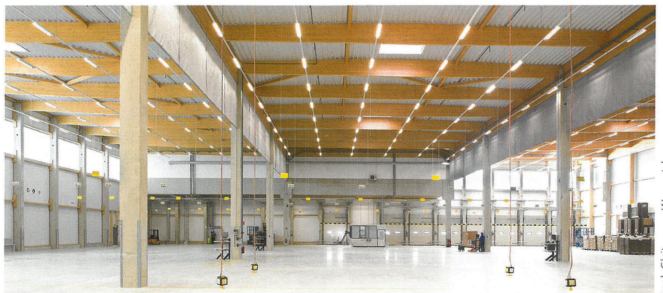
Lichtsituation im Inneren der Halle.
